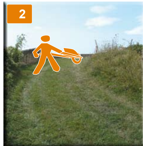
2 Les monteurs la transportent au sommet du four.
